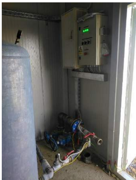
Slika 2.2.-1. Prostorija za smještaj hidrofora i komandnog ormara potopne bunarske pumpe
