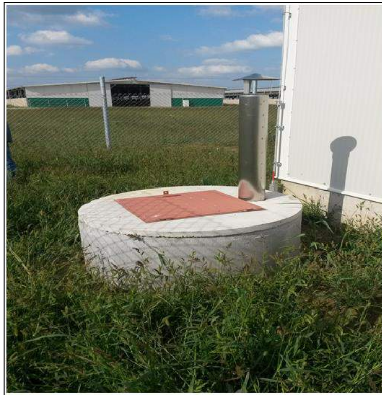
Slika 2.1.-3. Izvedeni eksploatacijski zdenac
